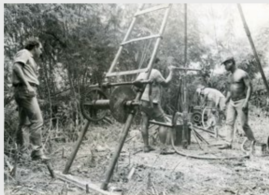
1993 - Engenheiro e trabalhadores fazem primeiras intervenções em terreno do Centro Sindical.
